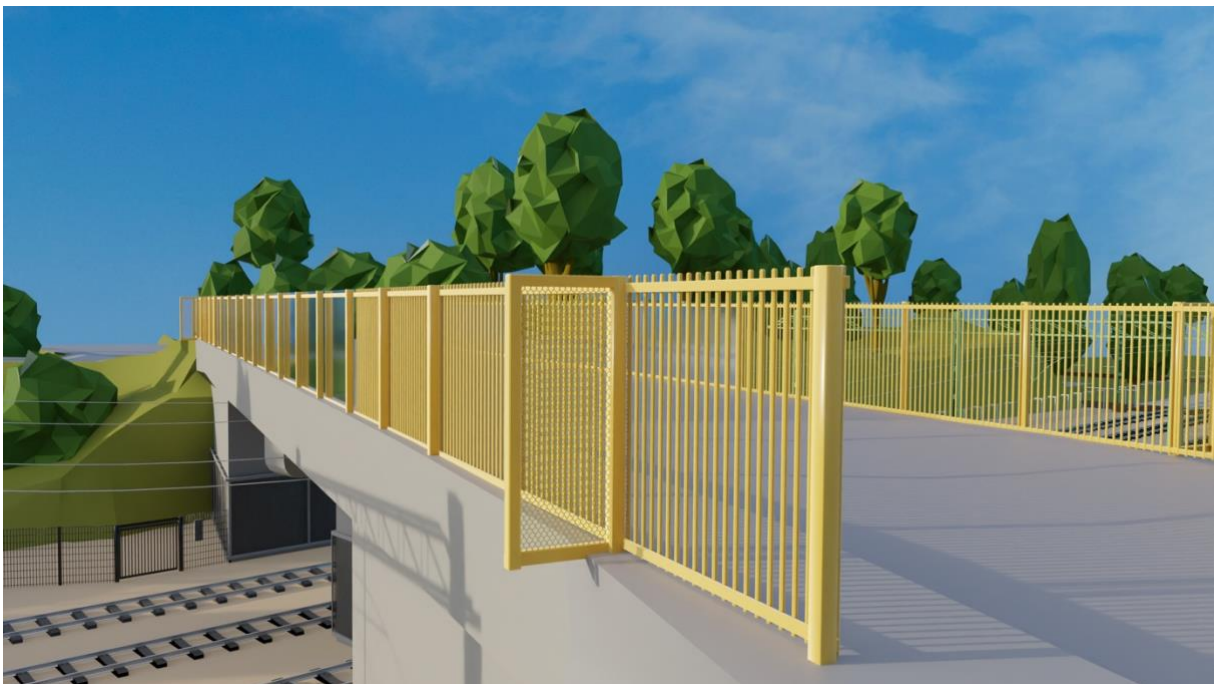
Figur 10. Suicidskydd på bron som går över järnvägen. Notera "förbiklättringsskyddet" som gör det svårare att klättra från brofästet och ut över spårområdet. Uppmärksamma även att suicidskyddet är gestaltat på ett estetiskt tilltalande vis, eftersom bron ligger på en central plats i tätorten, vilket i regel innebär högre krav på gestaltning.
