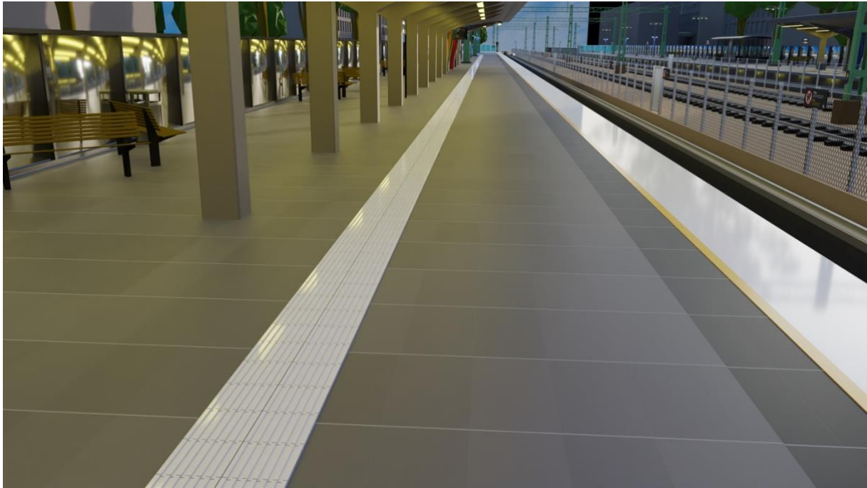
Figur 16. Till höger i bild syns den gula linjen som markerar plattformskanten. I mitten finns ett gångstråk för synnedsatta med taktila markeringar. Plattformen lutar svagt från spårområdet för att inte obromsade vagnar av misstag ska riskera att rulla ner på spårområdet. Plattformen ska vara väl upplyst för att undvika mörka partier med begränsat siktfält och låg social kontroll.
